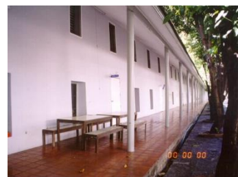
อาคารแถวเต่ง
